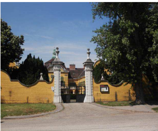
A Nagytétényi Kastély bejárata
