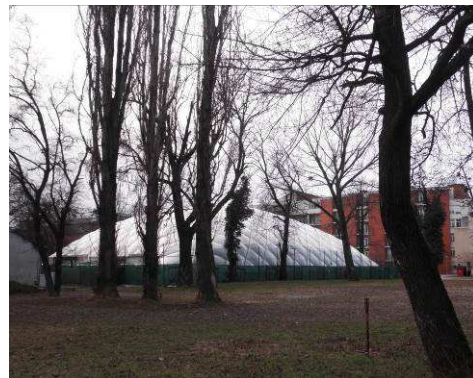
Könnyűszerkezeti építmény a kórház területén
