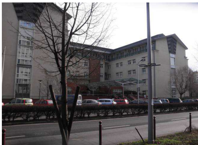
Szt.Imre Kórház átépített „A” épülete
