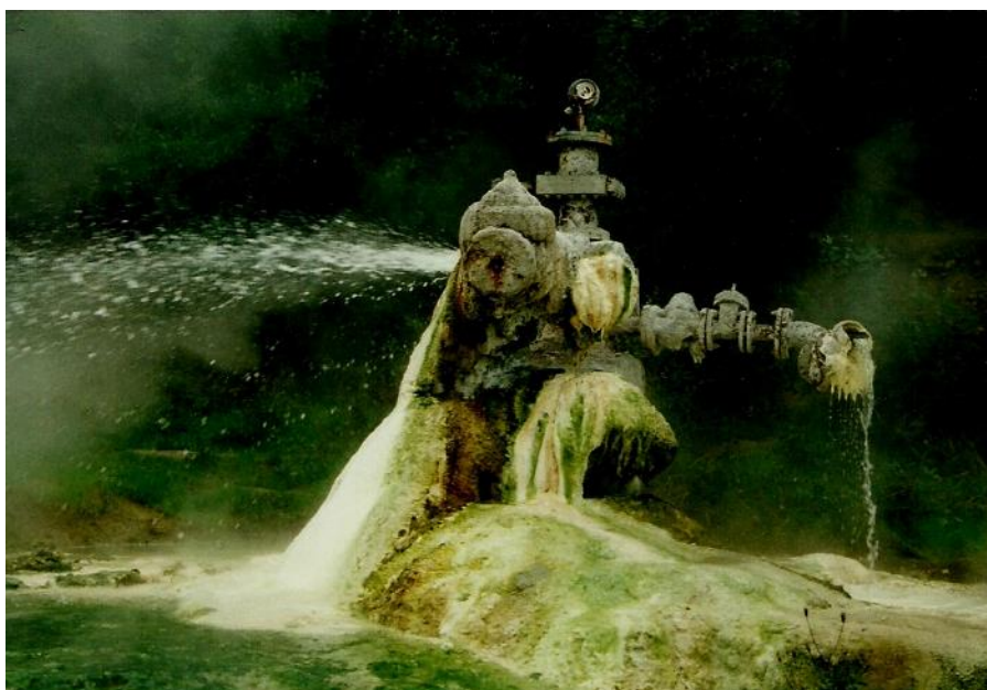
Az egerszalóki hőforrás kútfeje gélyszerű kénkicsapódással
