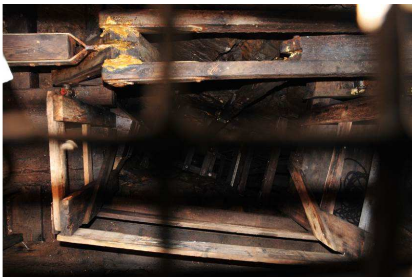
Emelőszerkezet oldalról és felülről (9 méter a kerék átmérője, ehhez 10 m magas kamrát kellett készíteni)
