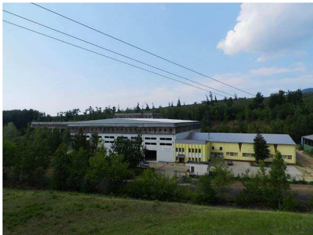
A felújított HAF az Altáró meddőhányója felől
