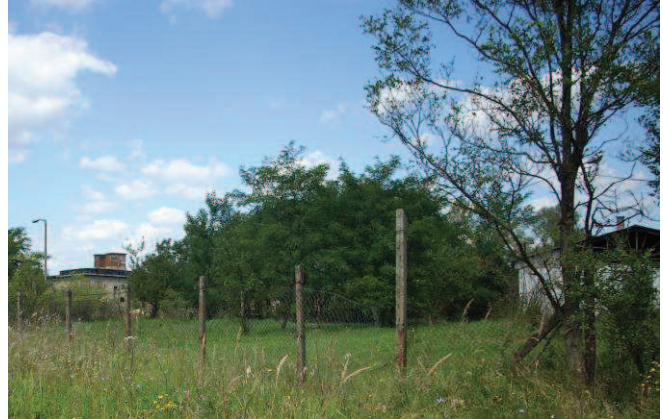
A II-es akna bekerített épületei
