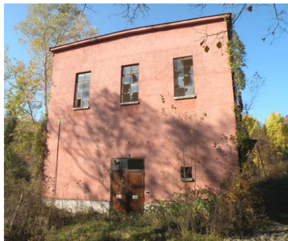
Károly-tárói trafóház érdekes szelőztetéssel
