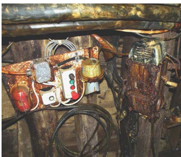
Kapcsoló berendezés a Károly-táró falán – nem éppen bizalomgerjesztő
