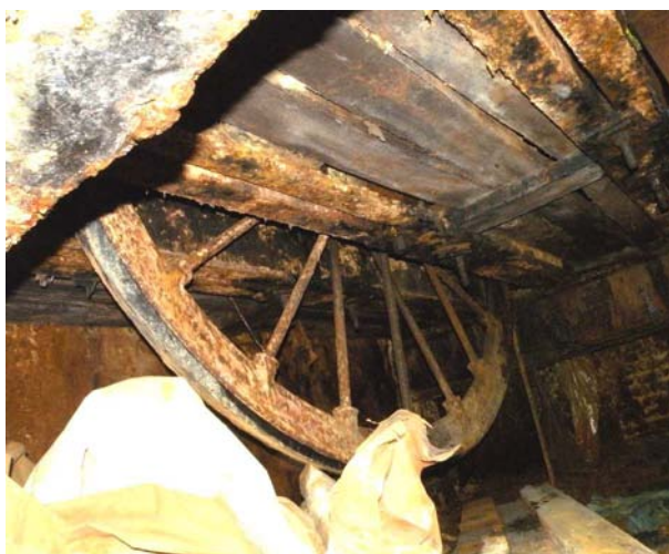
Küllős aknakorong a Károly-aknában, erre sem lehet már terhet bízni
