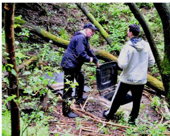
Walter-akna, kukatetős aknafedél Horváth Tibor felvétele
