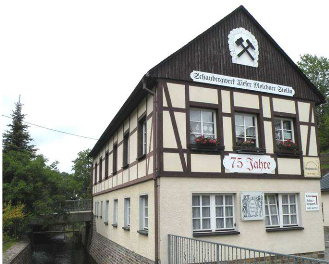
Szépen helyreállított fagerendás bányaépületek
